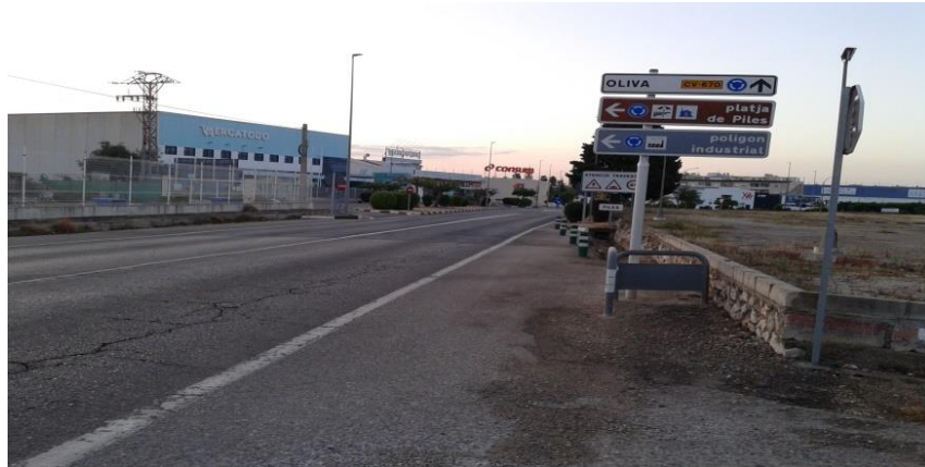
Imagen 4.1.2. Acceso a la parcela. (PARTIDA TERRANOVA PAMPOLS EN PILES)
